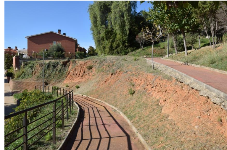
Fotografia 22. Punt 9: Aspecte general talús. Es pot observar el material acumulat al peu del talús.
