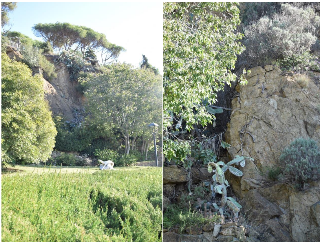
Fotografia 9. Punt 2. Esquerra: talús dintre del parc de Can Muntanyà. Dreta: detall de bloc inestable.
