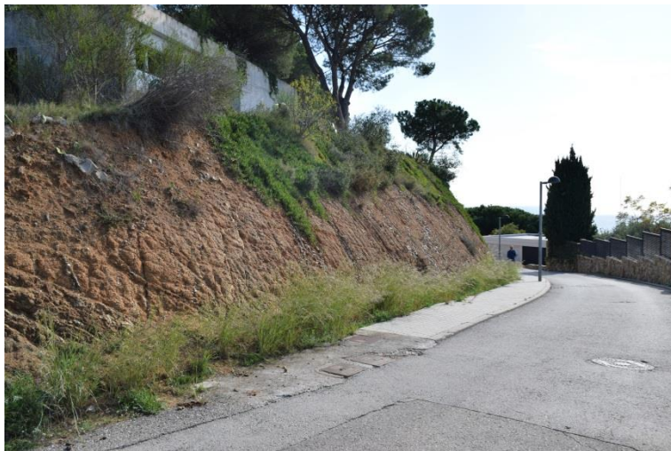
Fotografia 23. Punt 10: Aspecte general del talús.
