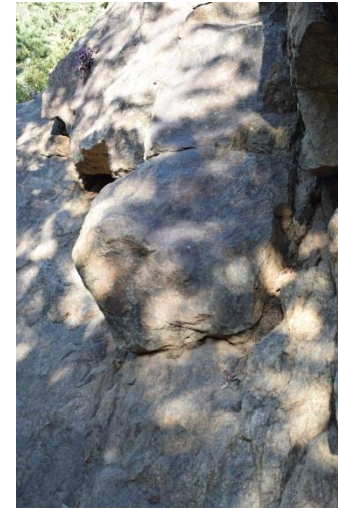
Fotografia 14. Punt 1: Detall de bloc inestable.
