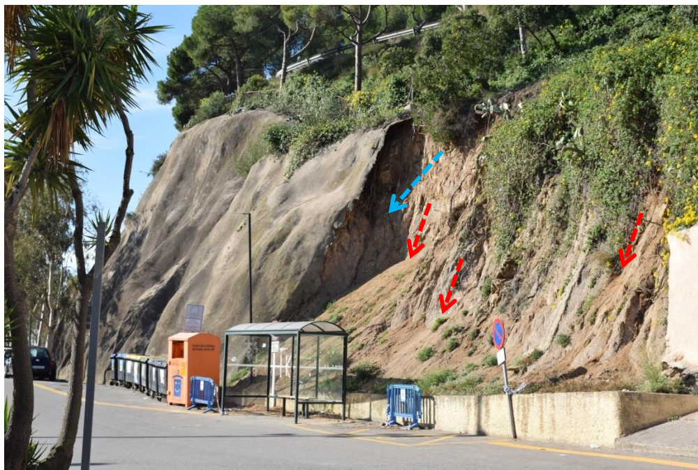
Fotografia 2. Esllavissades superficials de sauló (fletxes vermelles) al carrer d'accés a la N-II (punt 5). Fletxa blava indica buit de material darrera del formigó projectat.
