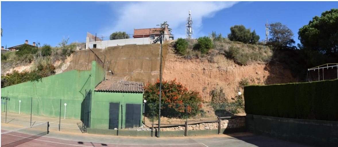
Fotografia 5. Talús al carrer Fornaca (punt 13). Es pot observar el sediments quaternaris amb presència de nivells de tortorà i les obres de defensa de la casa situada per sobre.
