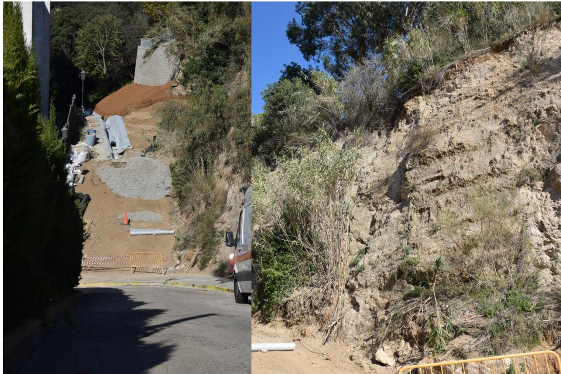
Fotografia 1. Esquerra: obres de reconstrucció del talús existent al punt 4, vista des del carrer del Molí. Dreta: Continuació del mateix talús en el carrer Molí.
