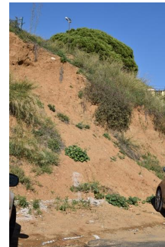
Fotografia 24. Punt 11: Aspecte general del talús.
