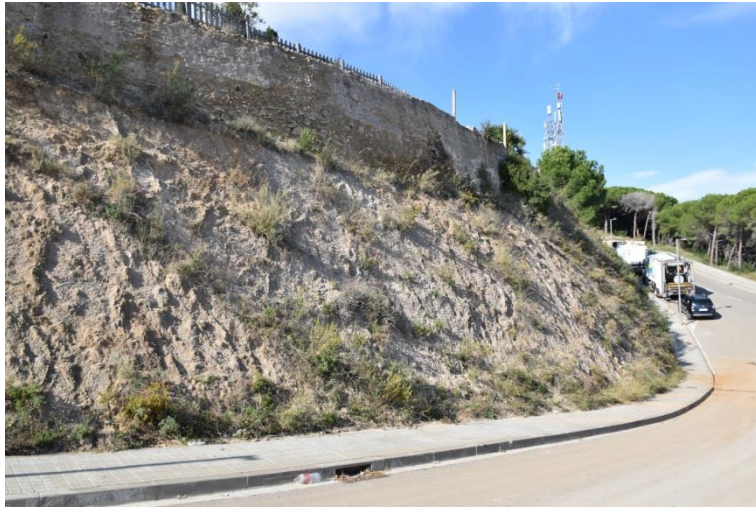
Fotografia 25. Punt 12: Aspecte general del talús.
