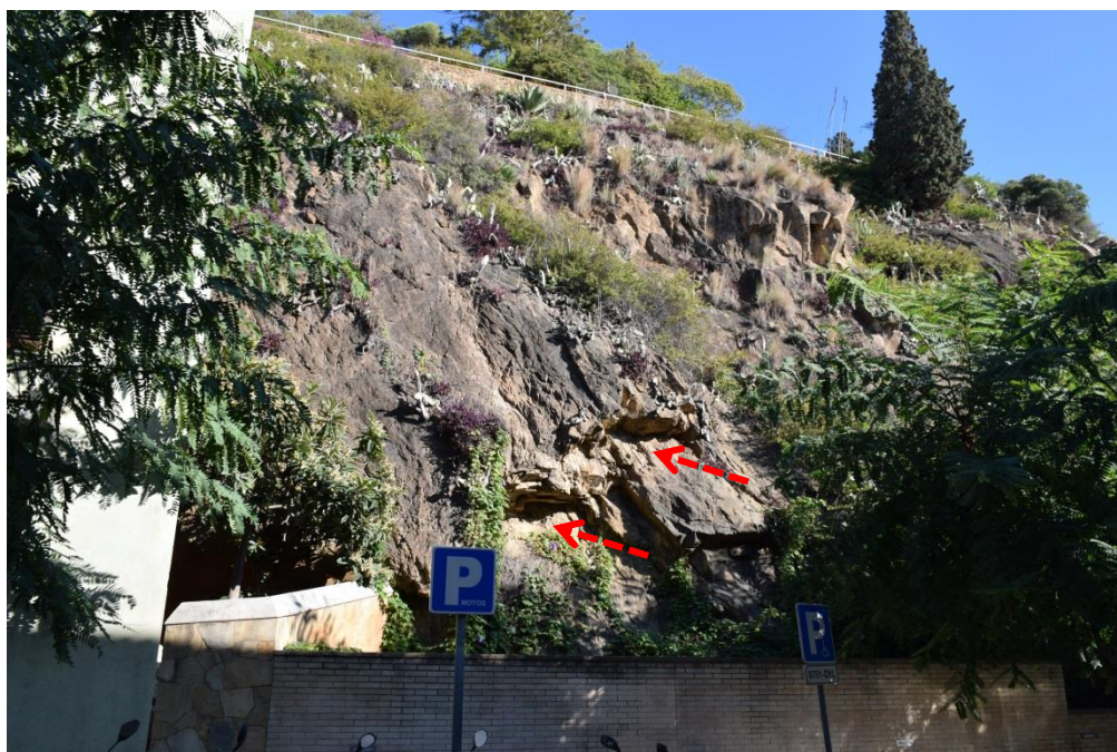
Fotografia 8. Punt 1: detall del talús on es poden veure cicatrius recents de blocs despresos (fletxes vermelles).
