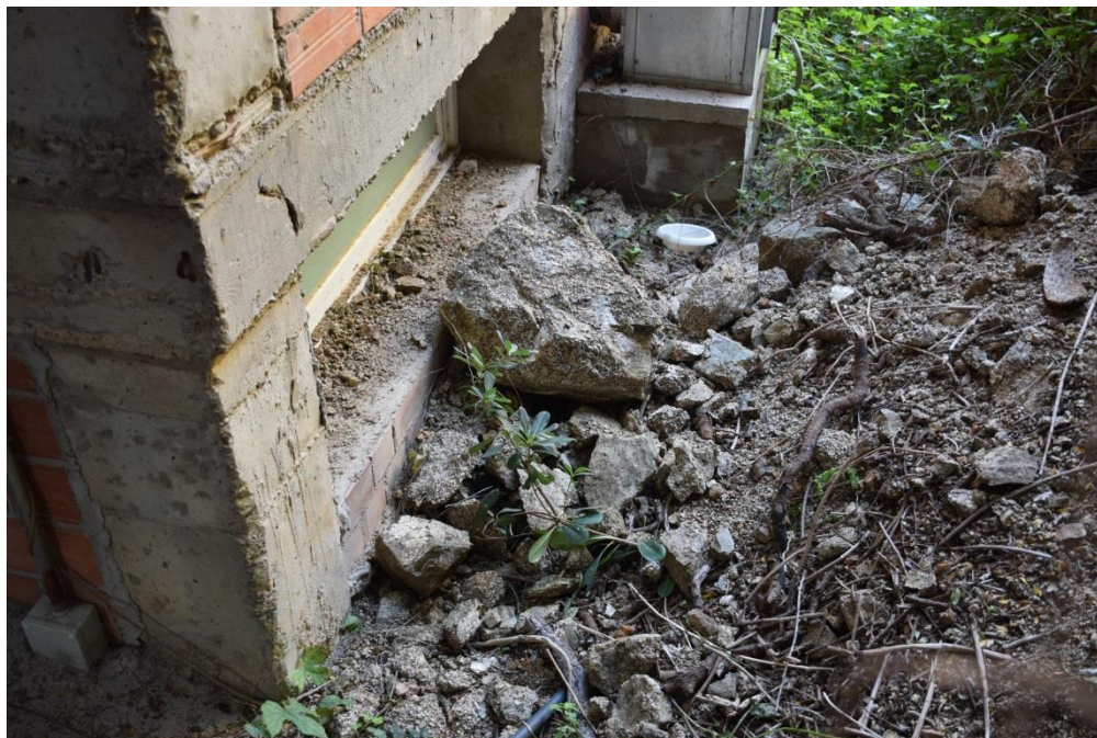
Fotografia 12. Punt 7: bloc després que ha arribat al peu dels edificis.
