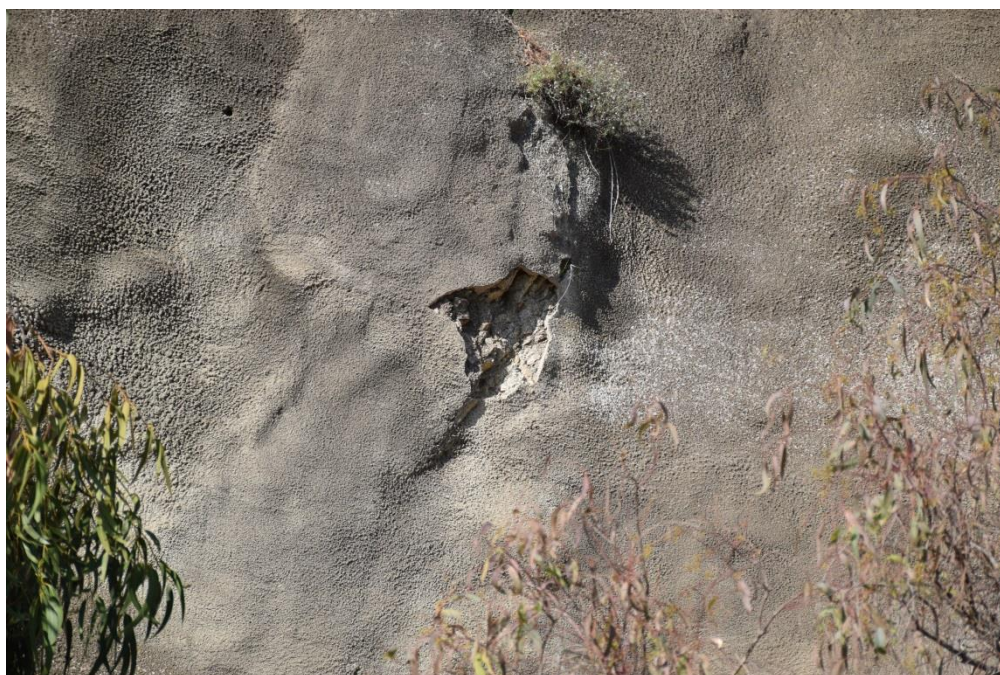
Fotografia 2. Esllavissades superficials de sauló (fletxes vermelles) al carrer d'accés a la N-II (punt 5). Fletxa blava indica buit de material darrera del formigó projectat.
