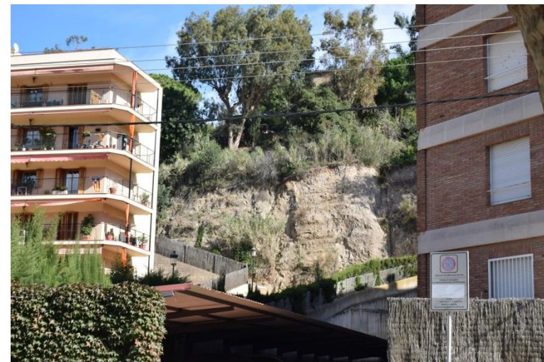
Fotografia 16. Punt 4: Aspecte general del talús.
